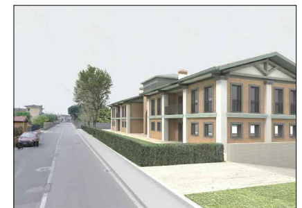
C - Rampa di ingresso parcheggi - Lato Sud
